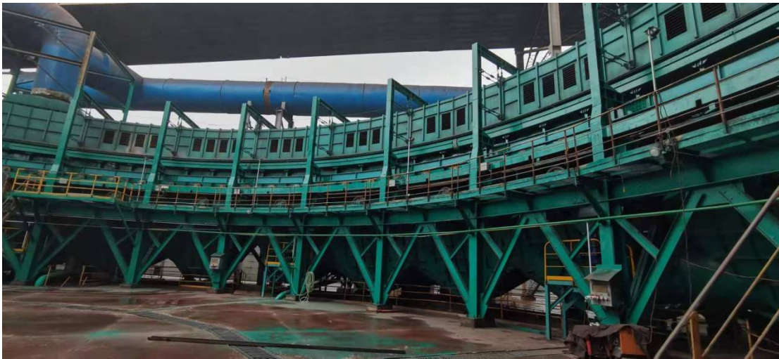
360 m 2 烧结环冷机节能改造
