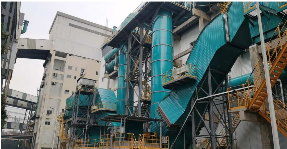
400 m 2 烧结烟气内循环节能改造
